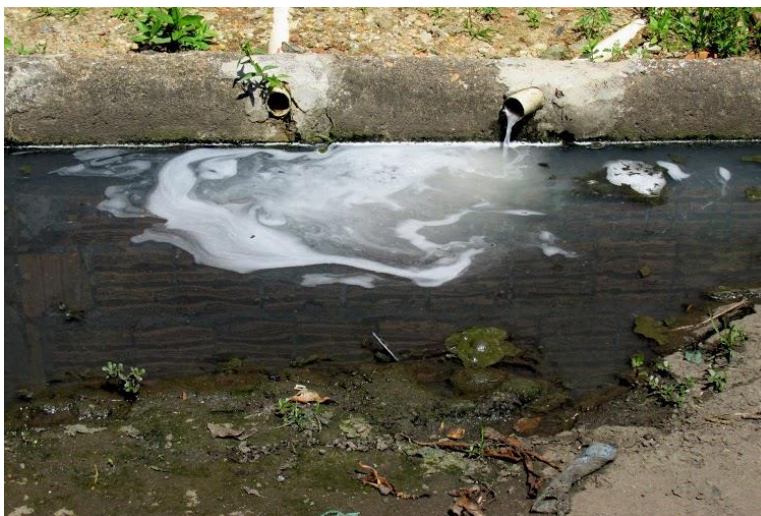
Figura 04: Dejeitos líquidos são despejados diretamente no meio - fio
