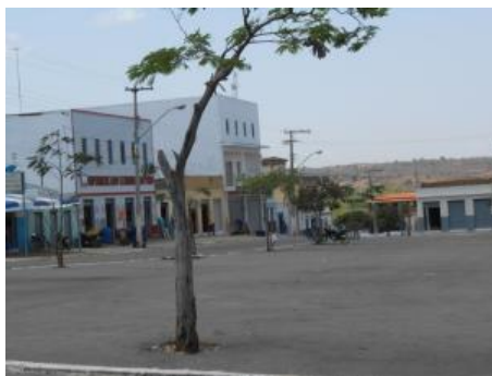
Figura 6 – Falta de sistema de drenagem pluvial na vila Bate-Pé, Vitória da Conquista, Bahia, 2014.
